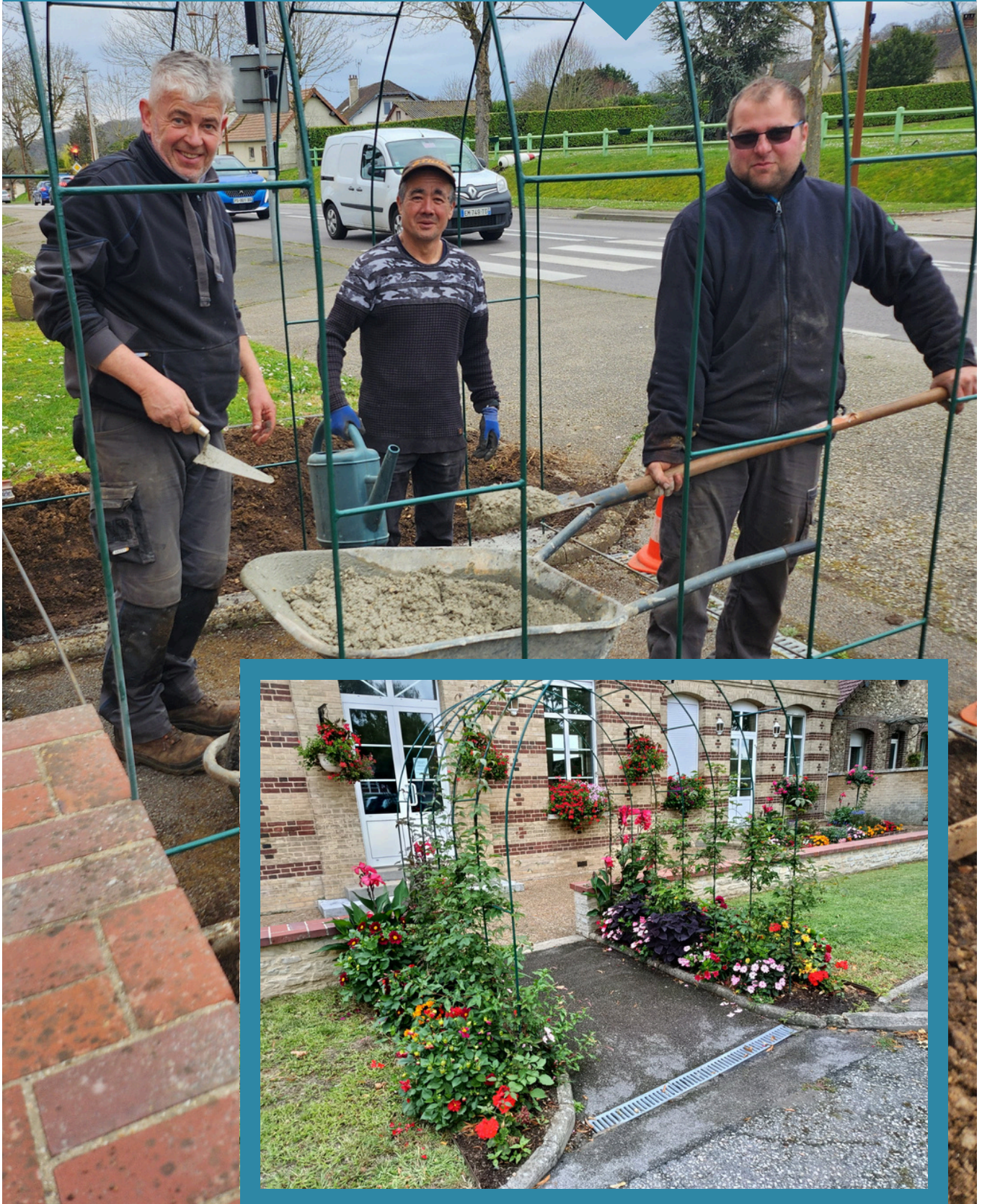
Réalisation et installation d'une arche à l'entrée de la mairie
